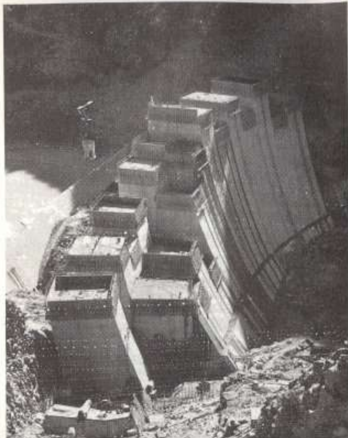
Diga in costruzione
