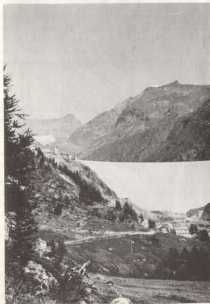
Diga ultimata, vista da valle.
