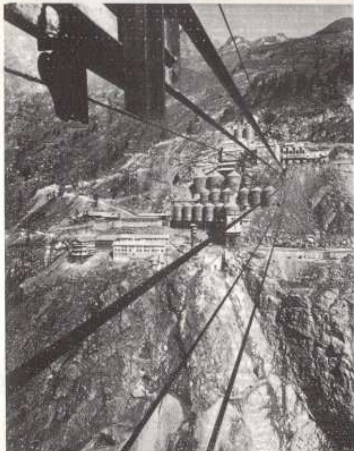
Impianto di betonaggio e dei blondins.
